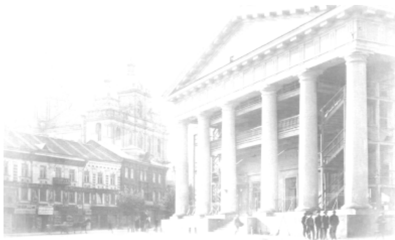
Vilniaus Rotušė bei už jos - šv. Kazimiero bažnyčia. Vilnius Town Hall and a Church of St. Casimir behind it.
