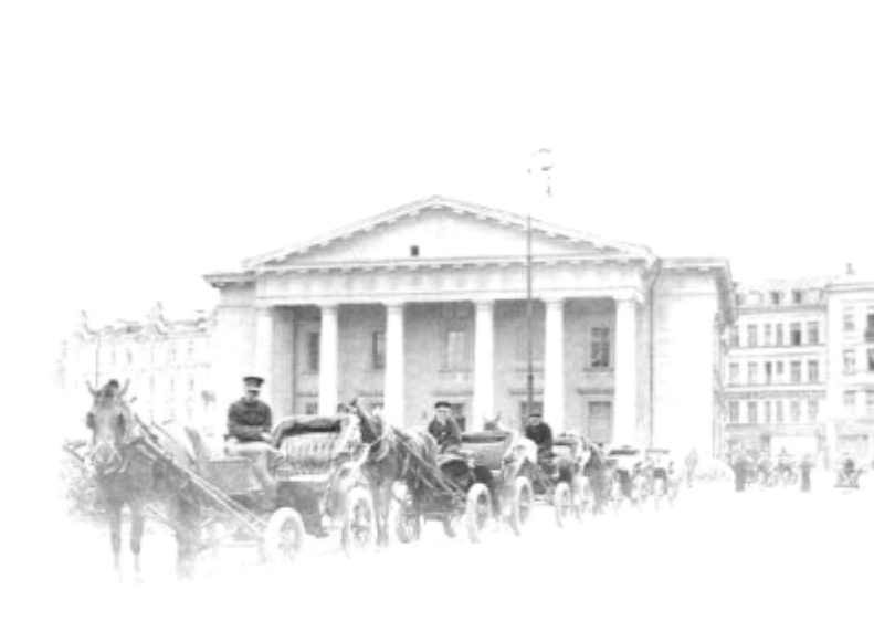
Miesto rotuš , už jos matyti viešbučio fasadas. Town Hall with the hotel building in the background.
